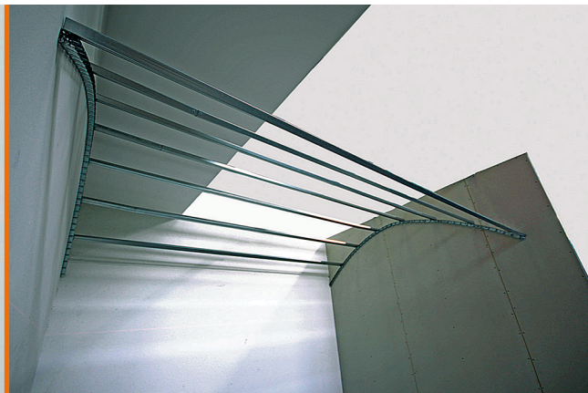
Stropni C-profil 50x27 ali 60x27 mm kot ogrodje.
